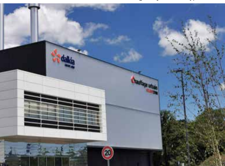
Chaufferie Surville - AkyVer ® Paneltherm Anti éblouissement
